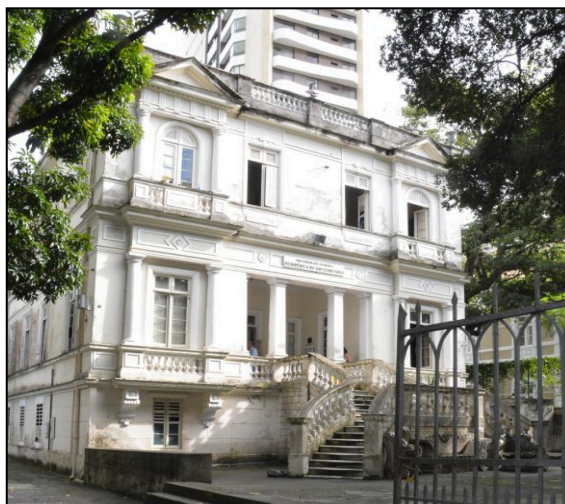
Figura 2 - Residência Universitária 1, no Corredor da Vitória
